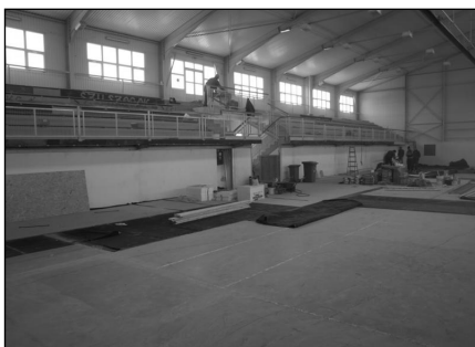
Sportcsarnok felújítás, kivitelezési hibák javítása
