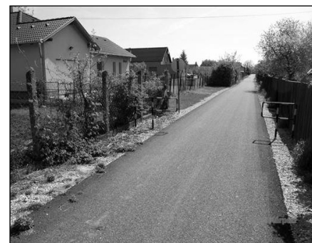
A "kisvasút" út felújítása
